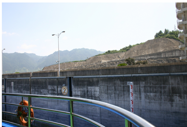
in der fünfstufigen Schleuse am Drei-Schluchten-Stausee
