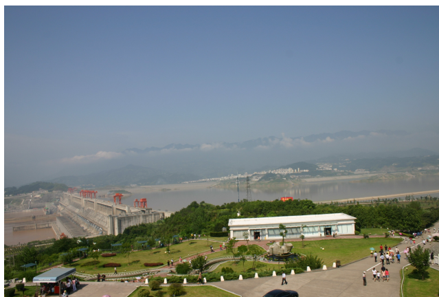
An der Staumauer des Drei-Schluchten-Stausees
